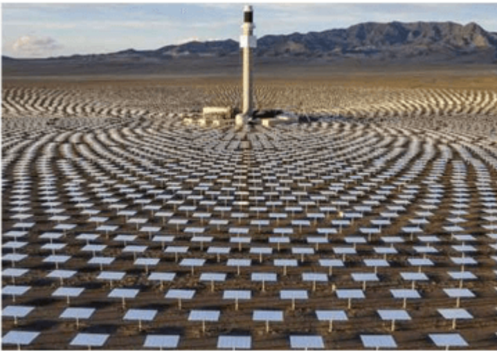
太阳能光热电站
