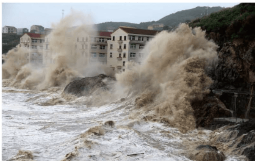
图 3-1-12 2018 年 7 月台风入侵浙江沿海地区
