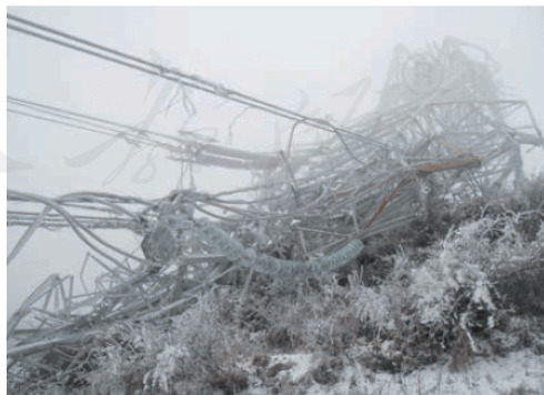
图 6.8 寒潮破坏输电线路
