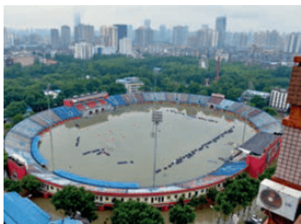
图 6.1 2016年7月6日武汉新华路体育场内的积水
