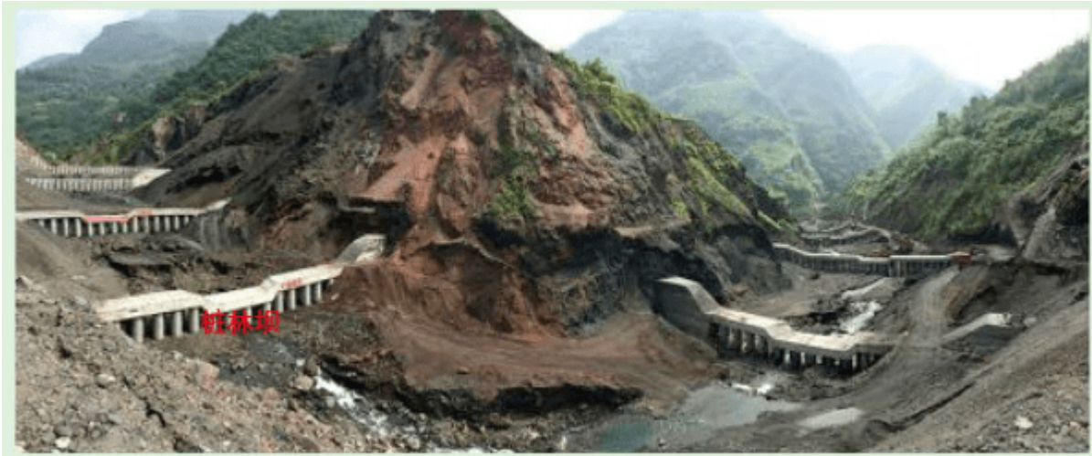
图 3-2-1 都坝河上游物源区建造的桩林坝
