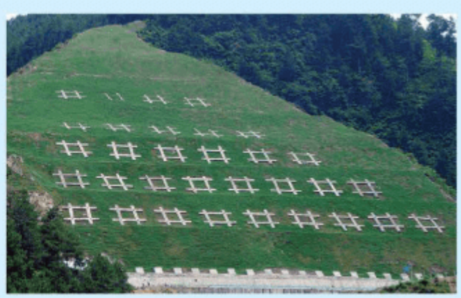
图 3-2-5 贵州省鹅山冲滑坡治理
