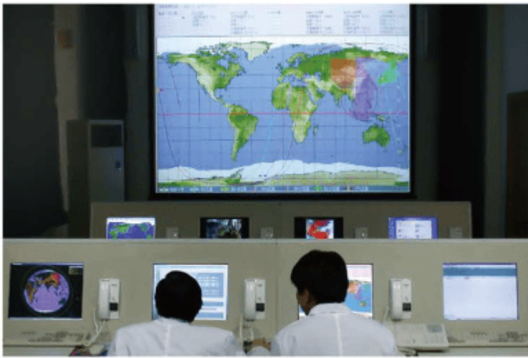
图 3-2-2 海洋卫星监测系统的控制机房
