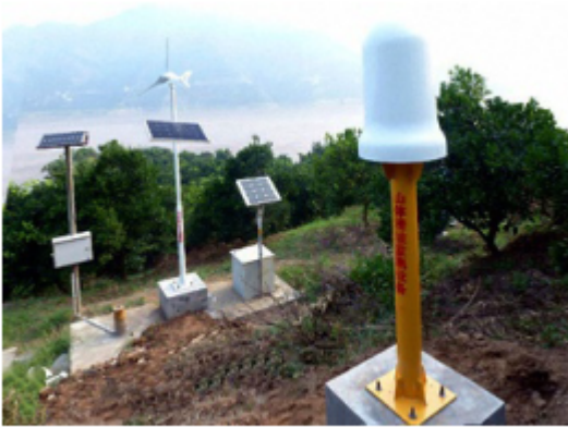
图4-3-8 卫星定位位移监测桩
