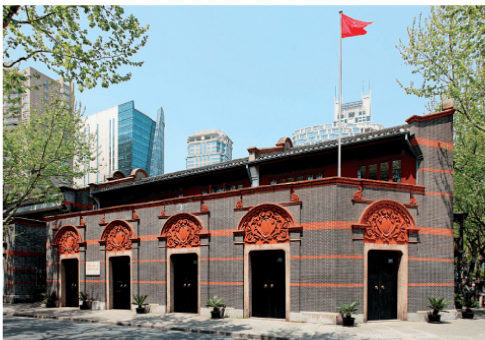
图 2-29 上海石库门建筑（中国共产党第一次全国代表大会会址）
