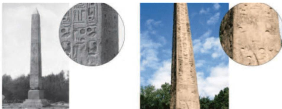
图 5-1-3 酸雨危害前的建筑（左）和酸雨危害后的建筑（右）
