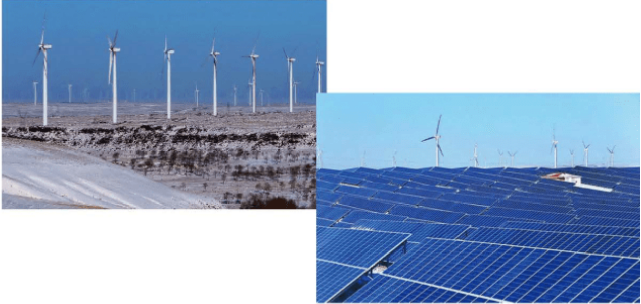
张家口的风电场和光伏电站
