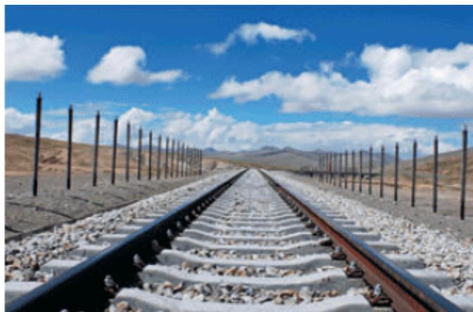
青藏高原日温差大。有些地方在冬春和秋冬过渡时期，土层反复冻融。当表层土冻结而下层土未冻结时，铁路路基不稳定，威胁列车运行安全。在这样的時候，插入地基下面的热棒可排出下层土多余的热量，使下层土保持冻结状态。
