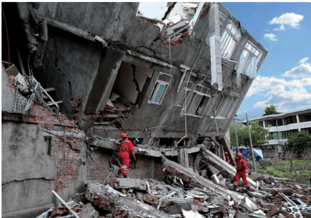
图 2-1-10 2014 年四川雅安地震造成的破坏
