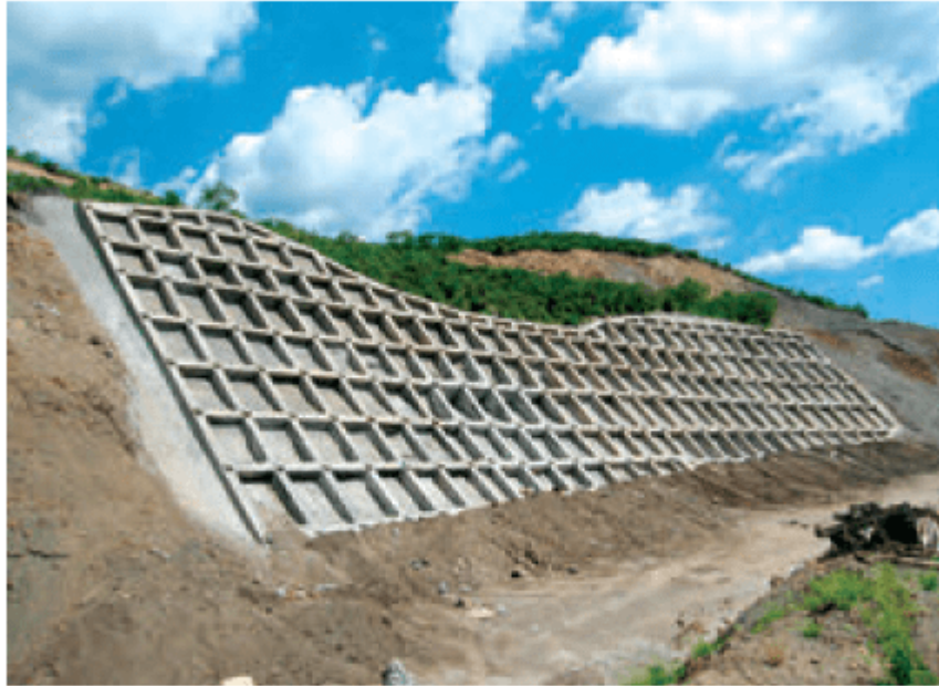
图 2-14 道路边坡加固
