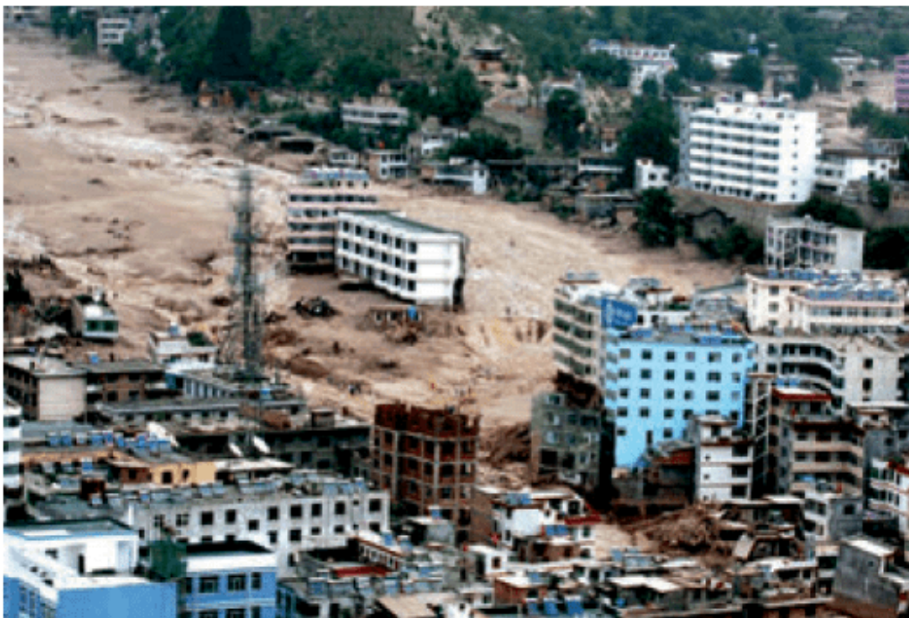
图 2-17 甘肃舟曲泥石流灾害现场
