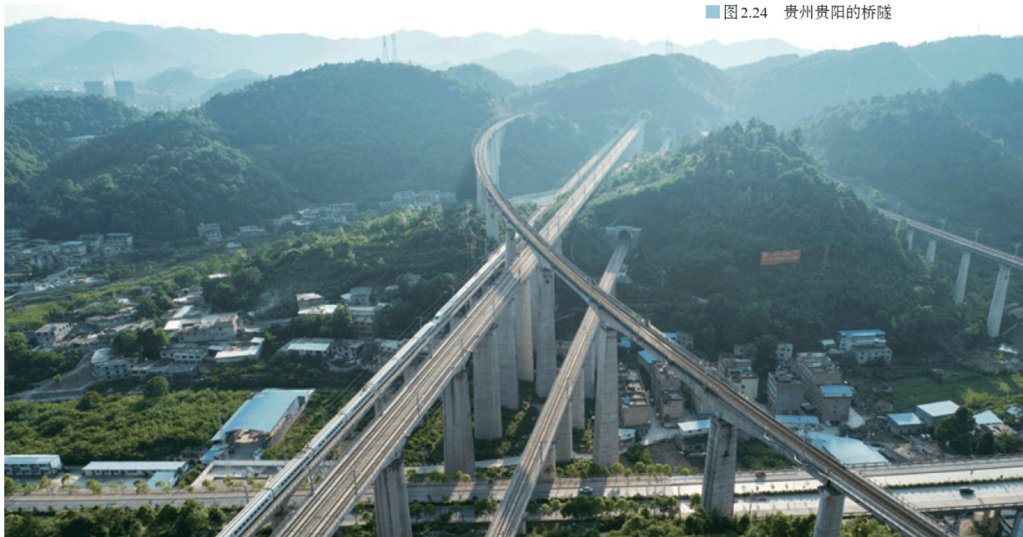
图 2.24 贵州贵阳的桥隧
