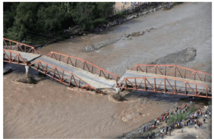
图 4-3-8 2017 年秘鲁沿海地区暴雨引发洪水灾害使多座桥梁断裂
