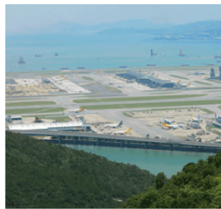
填海造陆： 香港国际机场位于香港特别行政区赤蠓角，1998年7月启用，占地1255公顷，其中75%是填海造陆而成的。2016年4月，香港国际机场第三跑道填海工程获批，计划在现有机场以北填海拓地。
