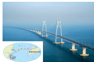
跨海桥隧： 港珠澳大桥跨越伶仃洋，东接香港，西接珠海和澳门，总长约55千米，是迄今世界上最长的跨海大桥。港珠澳大桥集桥、岛、隧于一体，其中海底隧道约6.7千米。通车后，从香港到珠海的驾车时间由3个多小时缩减为半个多小时。
