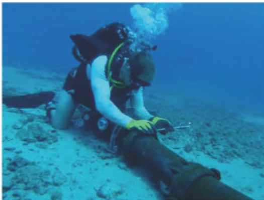
图2-3-13 海底电缆检修
