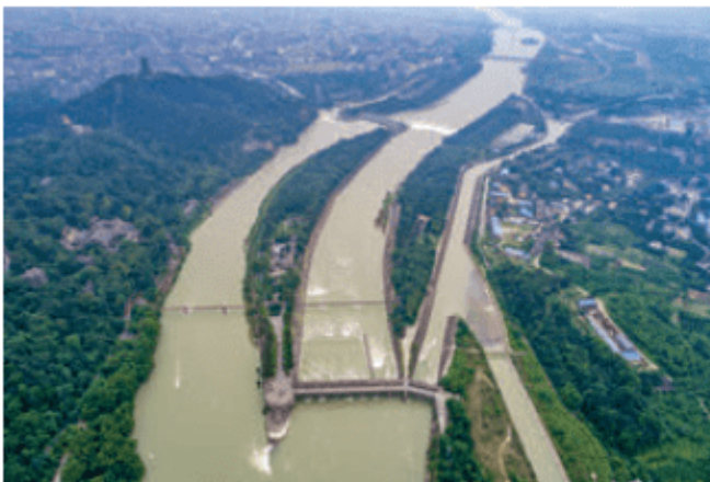
图 2.2 都江堰水利工程
