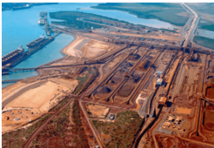
图 2.1 澳大利亚运输铁矿石的港口
