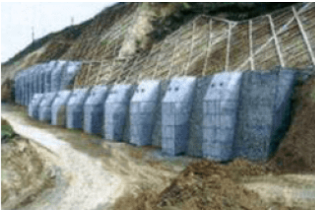
图2-1-8 防止山体滑坡的抗滑桩
