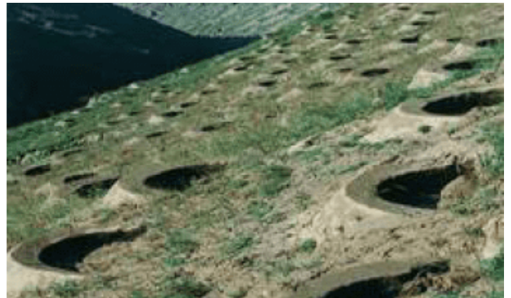
图2-1-9 储水和护坡的鱼鳞坑
