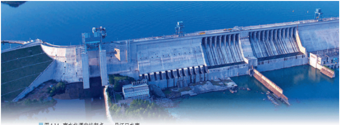
图 4.14 南水北调中线起点——丹江口水库
