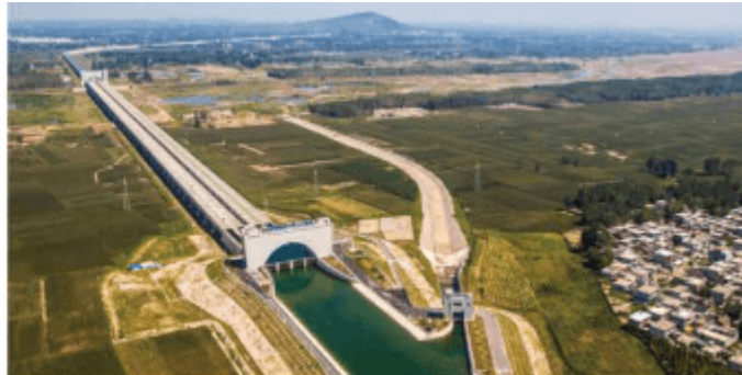
图 3-2-4 南水北调中线沙河渡槽
