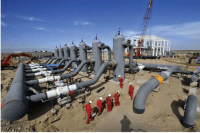
图 3-2-12 西气东输二线管道工程建设
