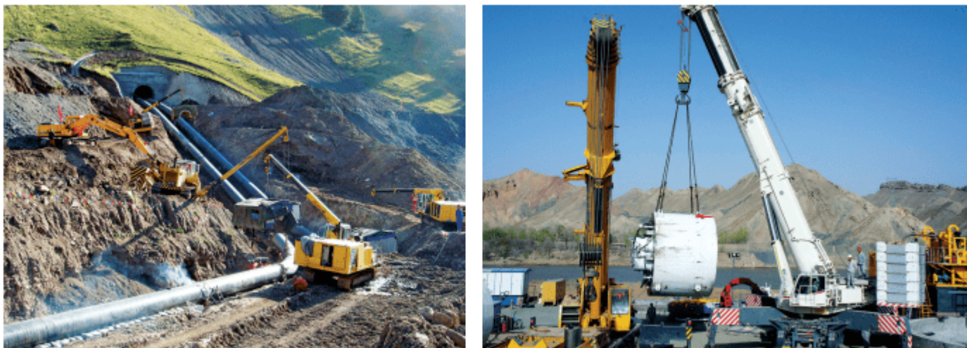
图 3-11 “西气东输”工程建设现场
