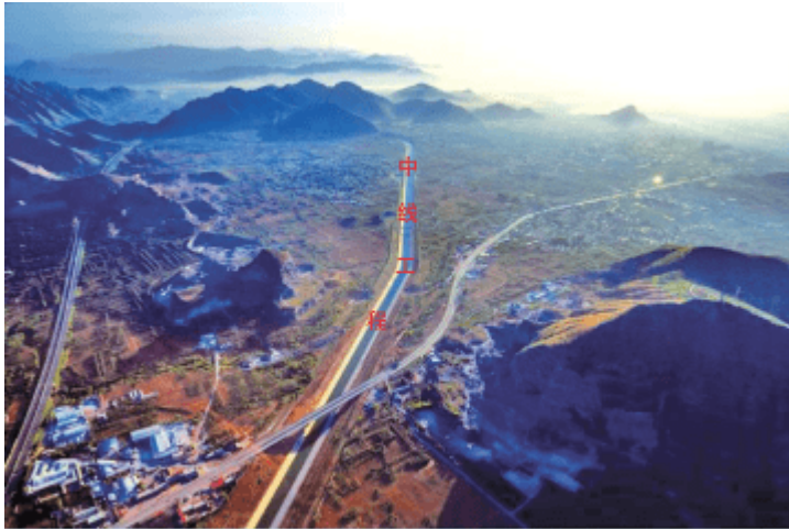
图3-3-1 南水北调中线工程
