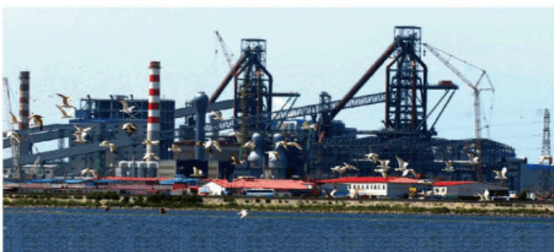
图 3-1-13 位于曹妃甸的首钢京唐公司
